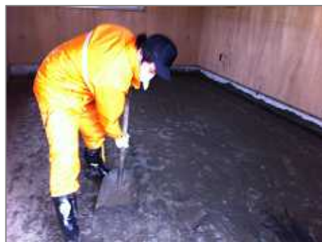
泥撤去作業の様子(高松様)
